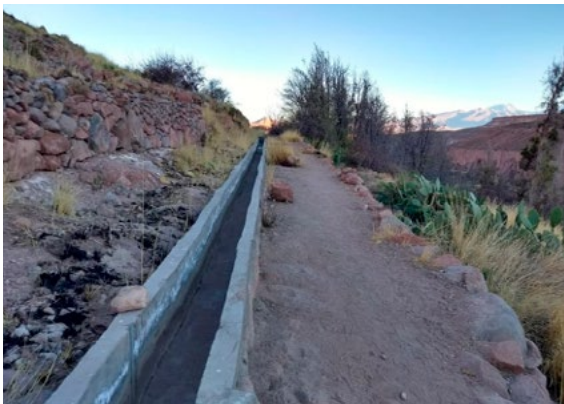
Arriba. Tunales en terrazas. 2018. Abajo. Canal de riego revestido en cemento. 2018.
